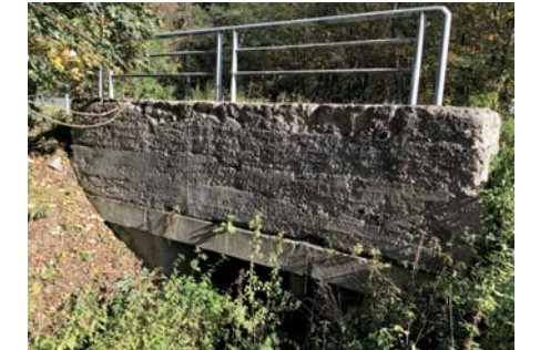
Bezlejoval – mostek přes zbytek mlýnského náhonu
