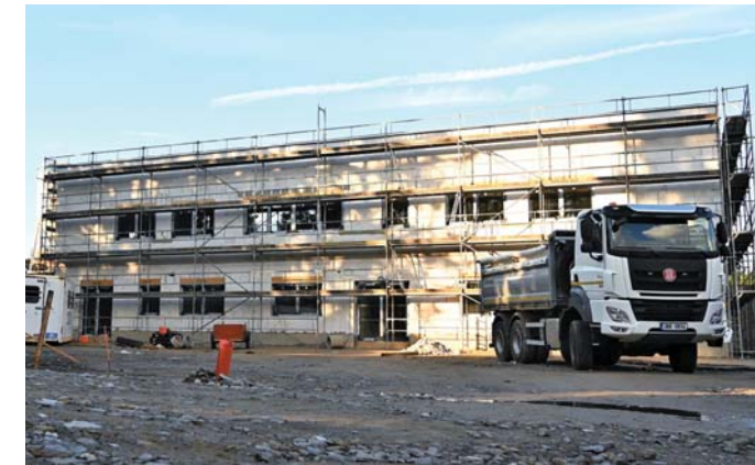
Výstavba hospice v Havlíčkově Brodě
