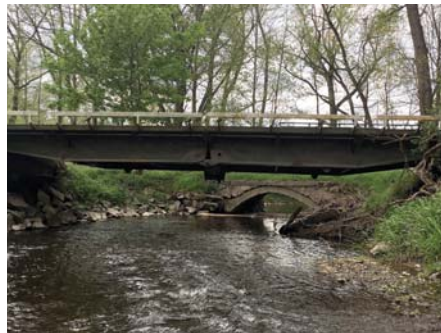
Hranice – Ovčácký most se starým můstkem
