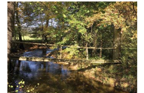
Bezlejoval – dřevěná lávka
